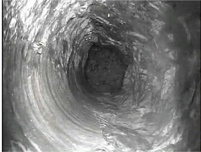
Figur 1 Utfall och konvergens i schakt efter raiseborrning.
